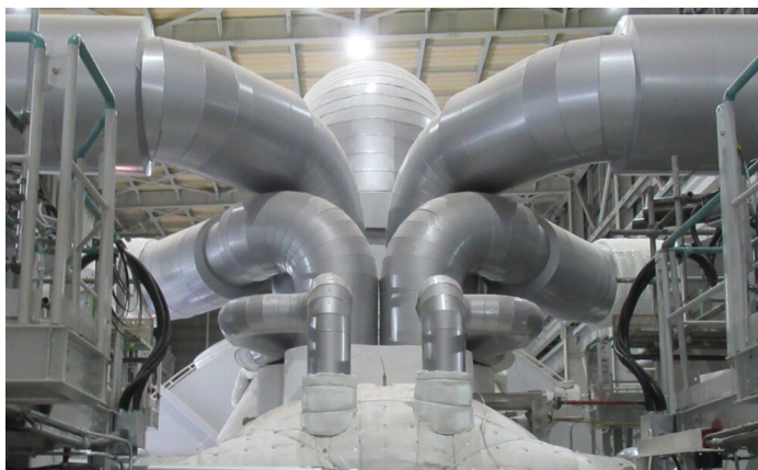
熱絶縁工事の一例
